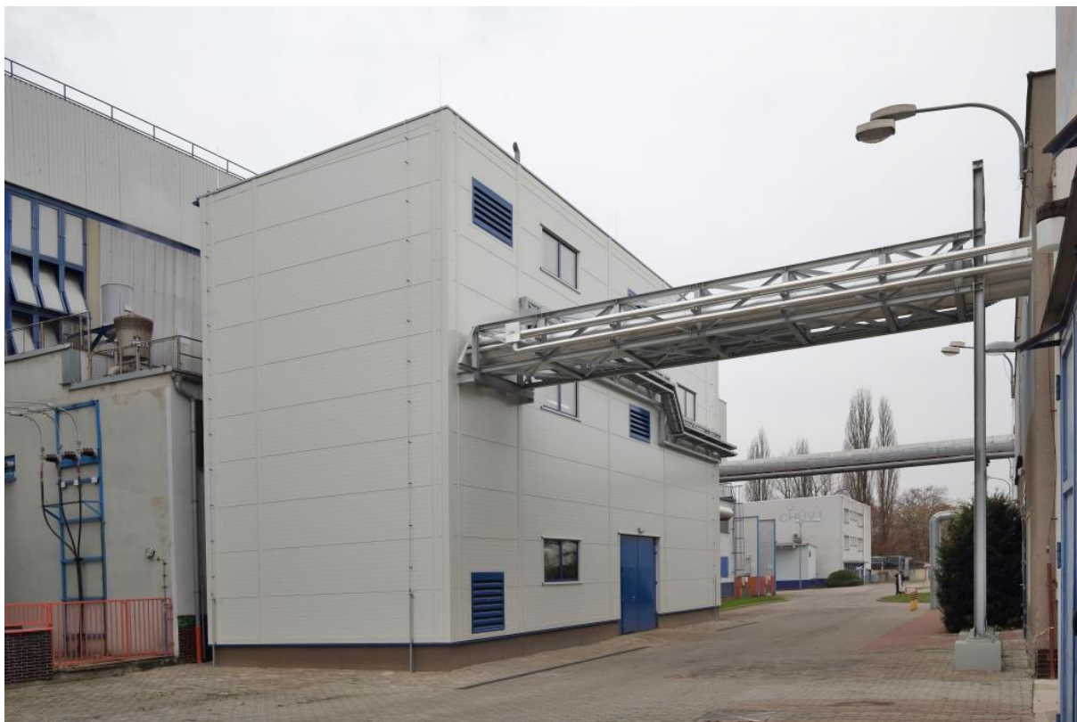
Nový přístavek strojovny s potrubním mostem
