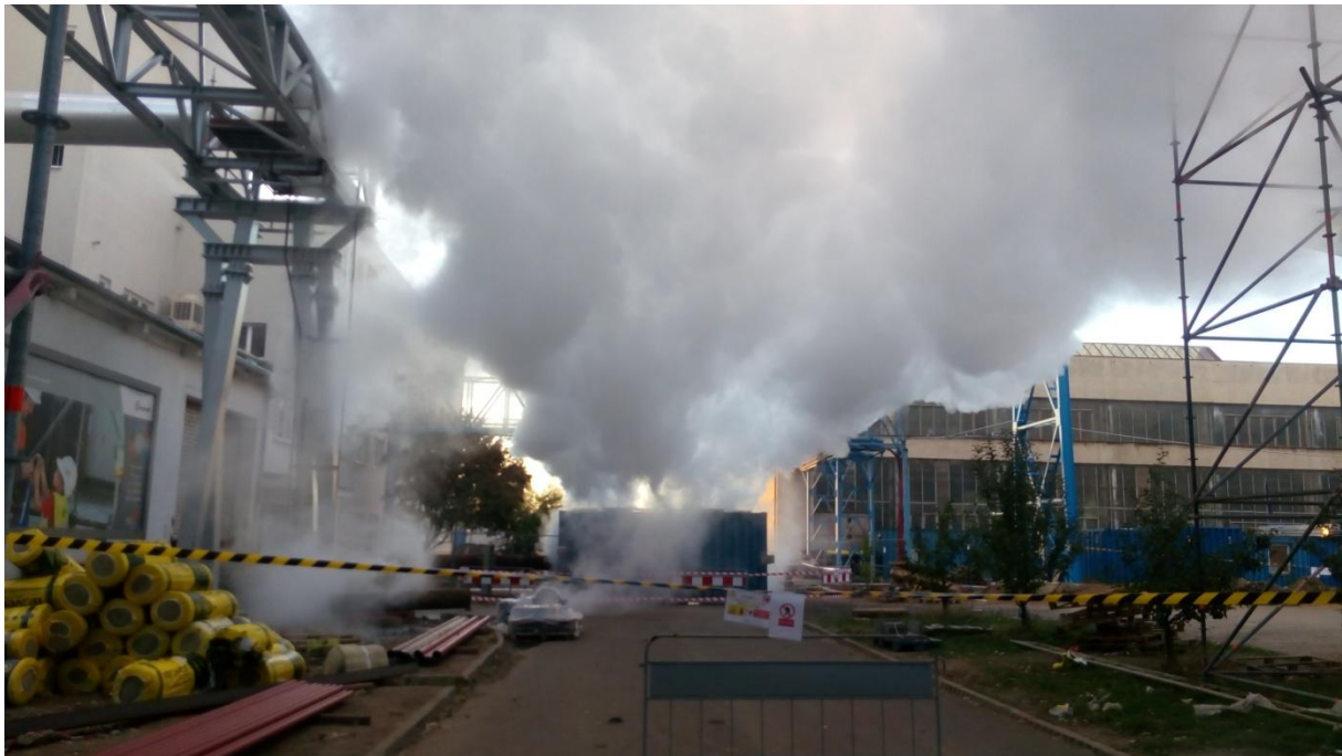
Mondi Štětí - profuk kotle a potrubí
