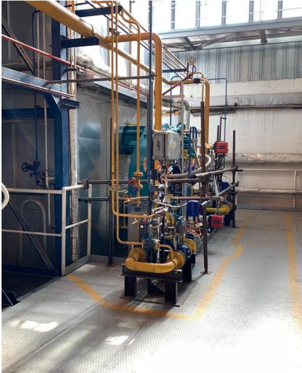
Finální vzhled přední strany plynového kotle po zabudování nových hořáků a připojení nových rozvodů vzduchu a plynu
