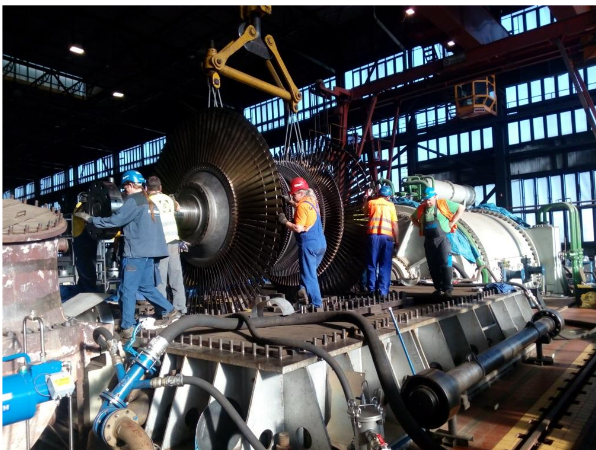
Chvaletice - instalace NT rotoru po opravě
