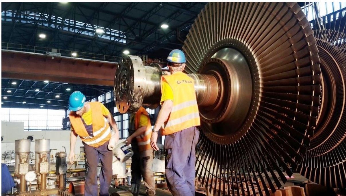
Chvaletice - vyjmutí NT rotoru TG
