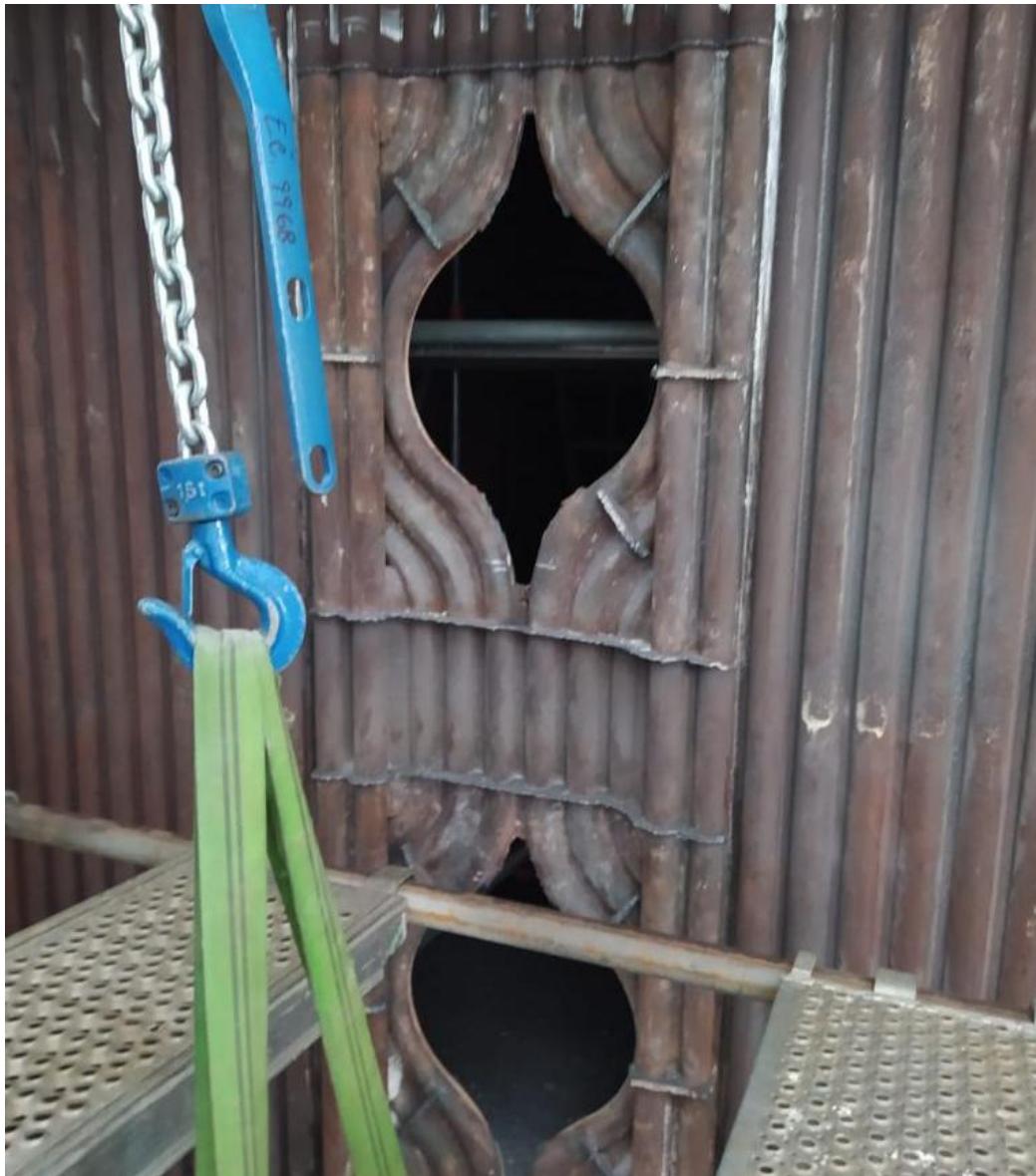
Obnažená přední stěna plynového kotle s otvory pro hořáky
