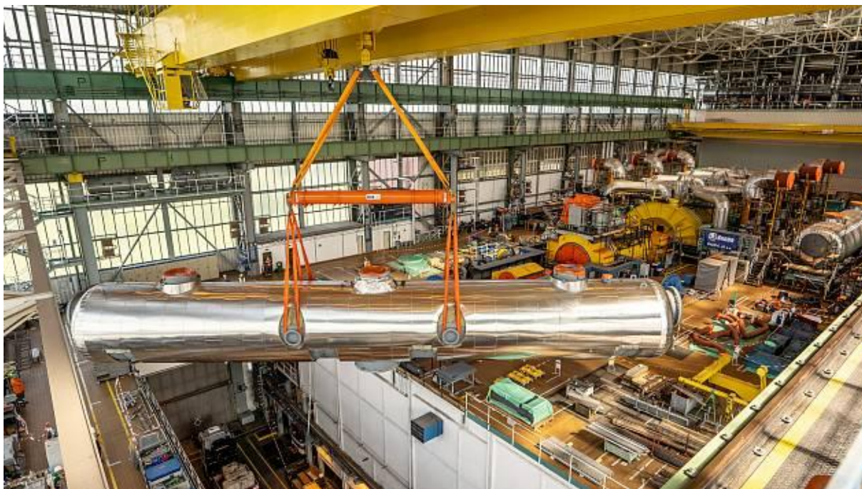
Transport nového separátoru
