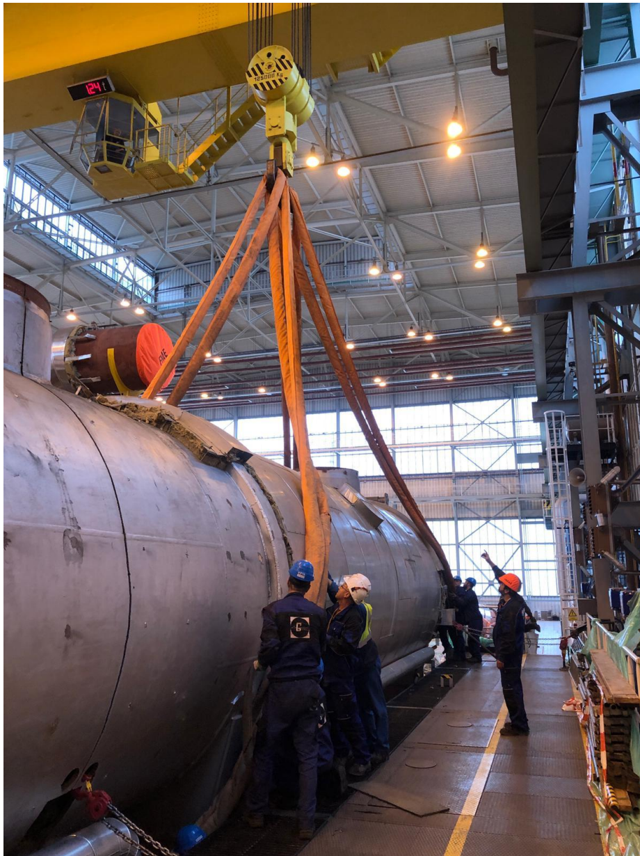
Příprava pro zdvih a transport původního separátoru
