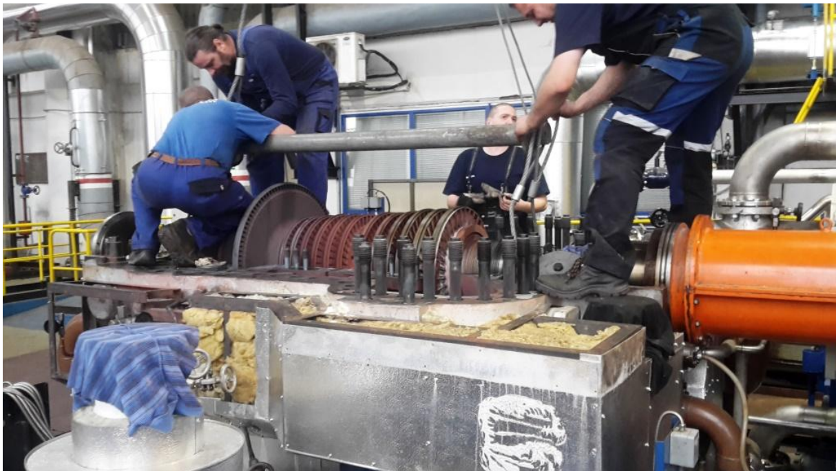
Teplárna ČB - příprava vyjmutí rotoru TG z tělesa
